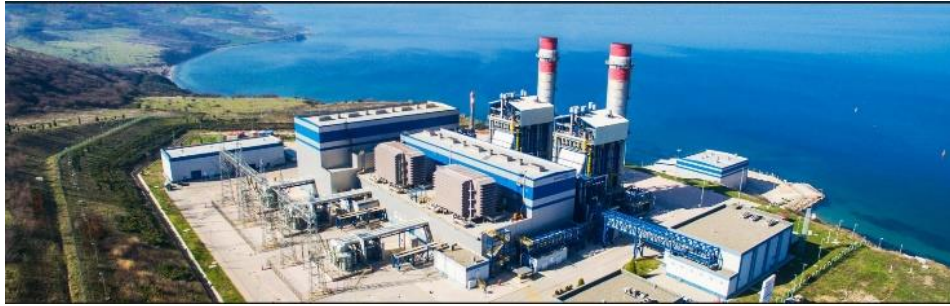
Fig. 1 EnerjiSA Üretim Bandırma-I natural gas combined cycle power plant
