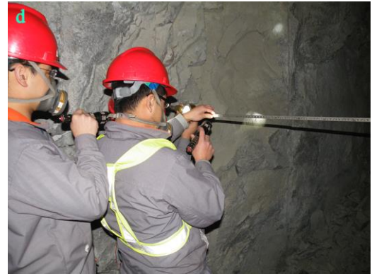
(d) convergence measurement using a convergence meter
